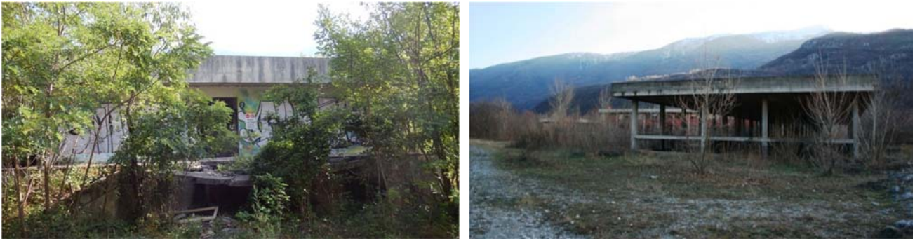
Figura 10 – Area di progetto con edifici incompiuti in stato di abbandono
