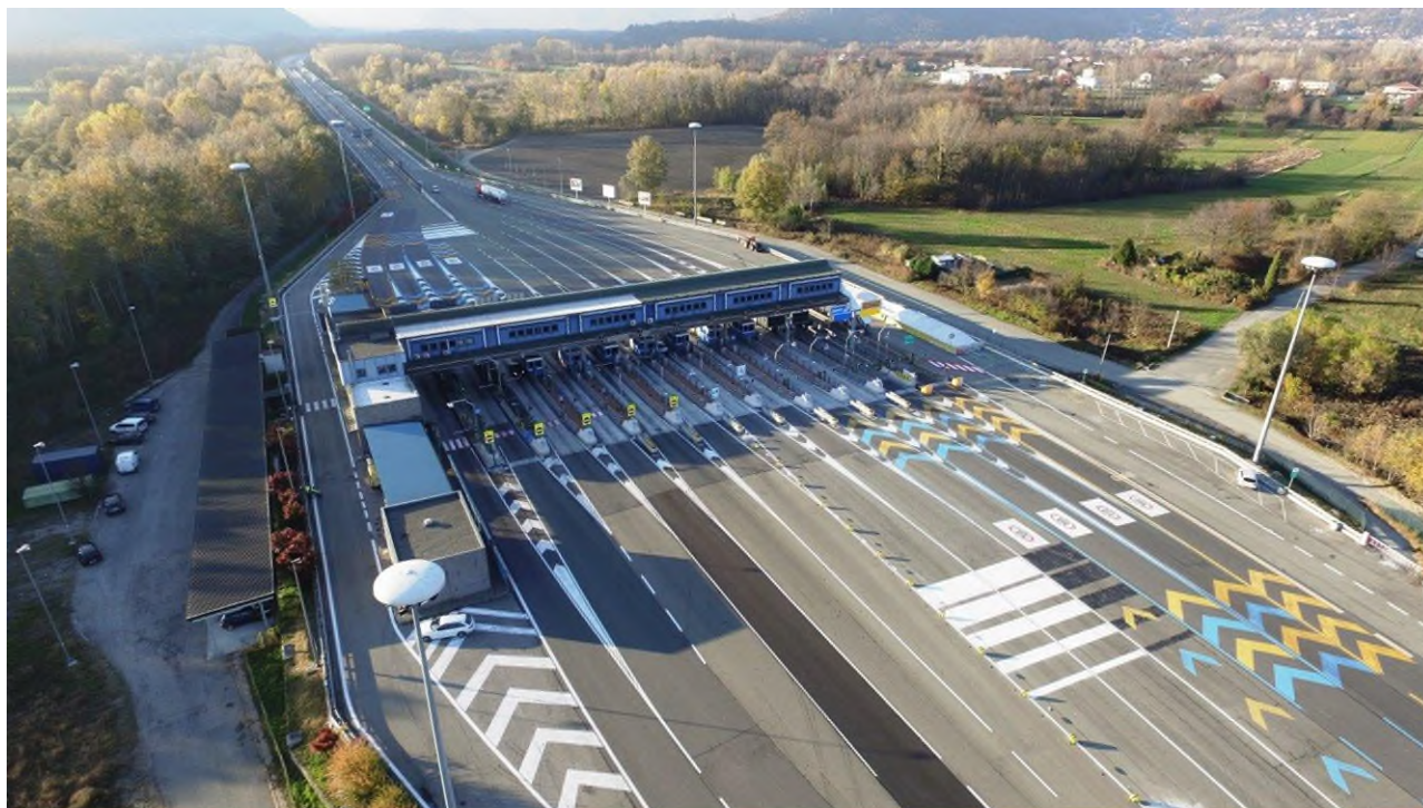
Figura 5 - Barriera Autostradale di Avigliana
